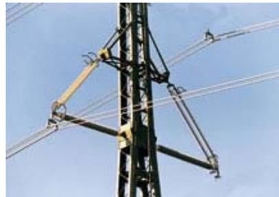
420 kV Isoliertraverse, errichtet im Jahr 1998
