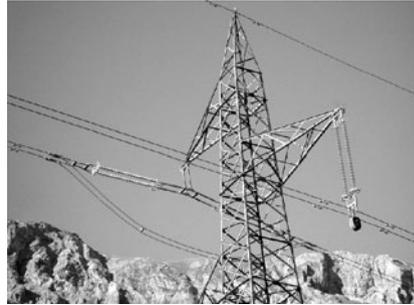
**Abb. 2.6** Tragabspannung
