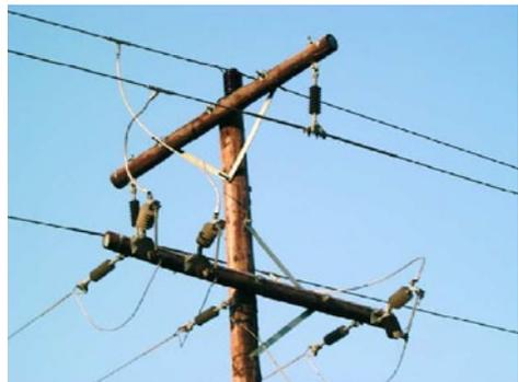
**Abb. 2.8** 20 kV Isolatoren am Holzmast
